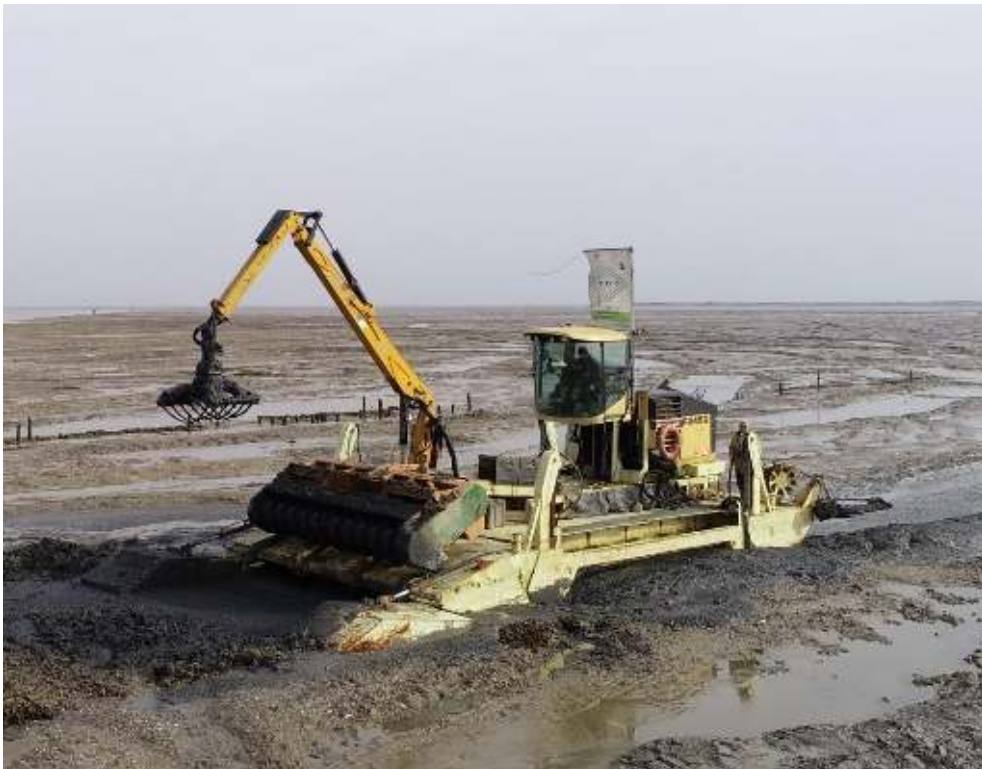
Photo n°3 : Machine 2 - Barge flottante utilisée lors du chantier 2020/2021. L'engin comporte un broyeur frontal et une griffe.
